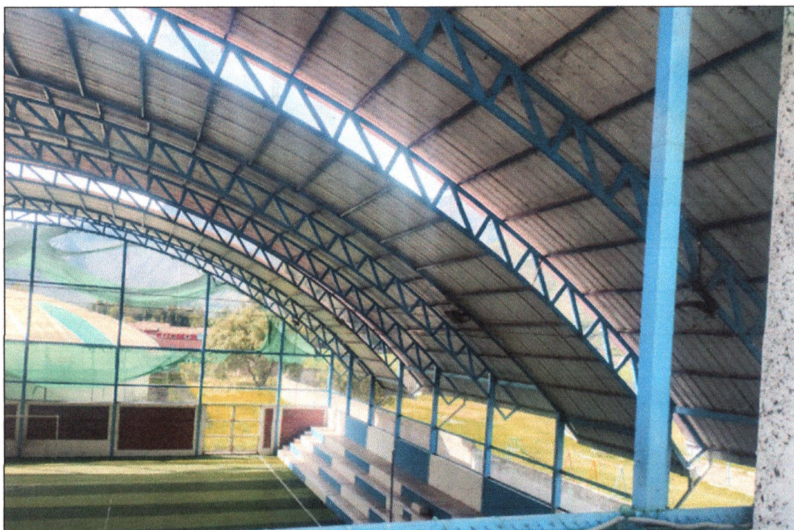
Figura N° 02: Ubicación de los reflectores para su sustitución lado derecho.
