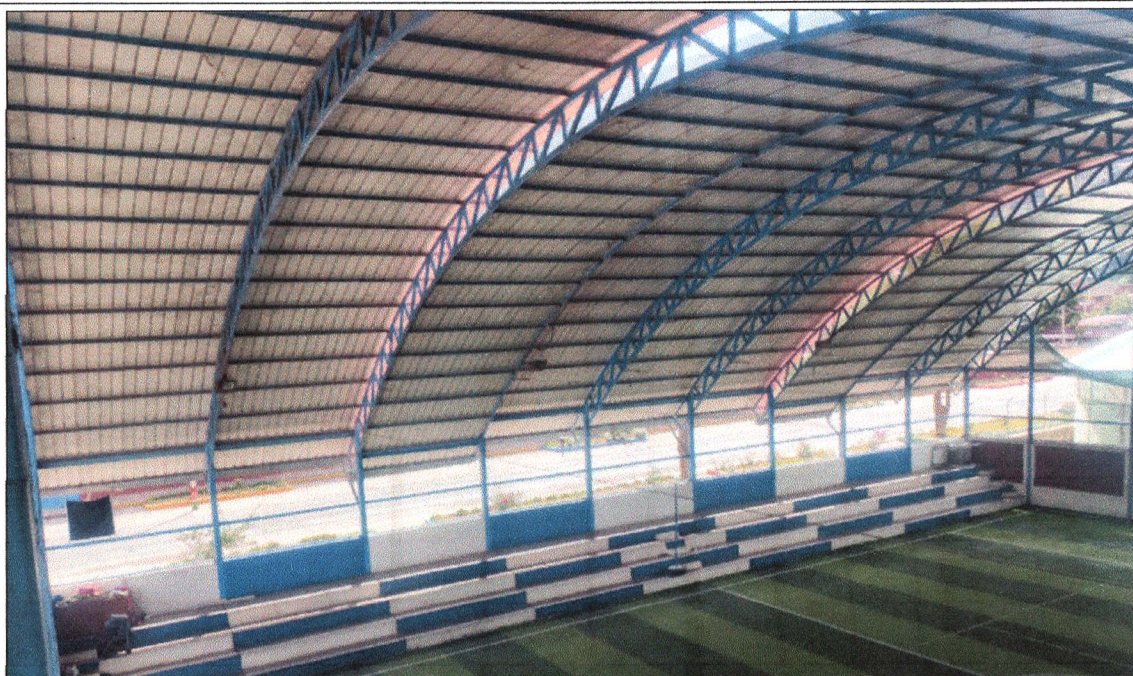
Figura N° 01: Ubicación de los reflectores para su sustitución lado izquierdo.
