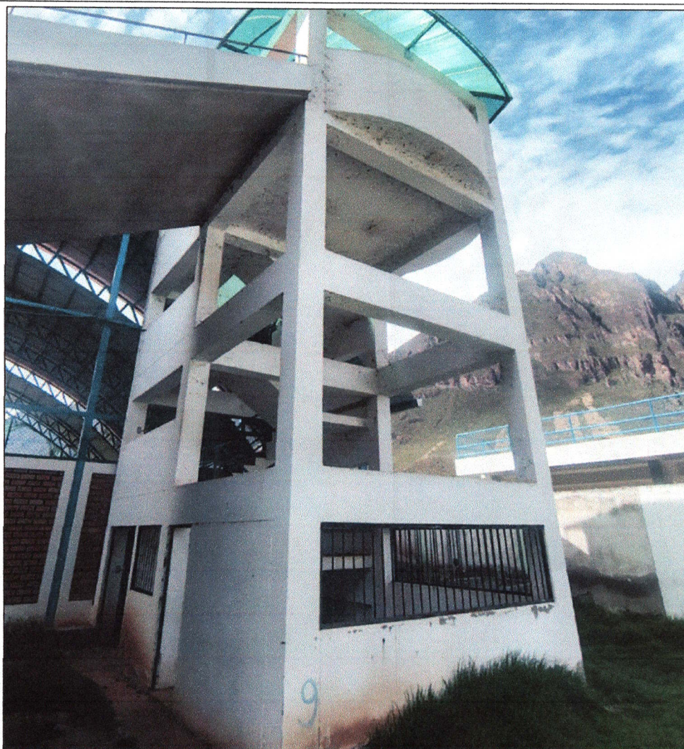
Figura N° 02: Estructura donde se colocará el fibrocemento por la parte exterior.
