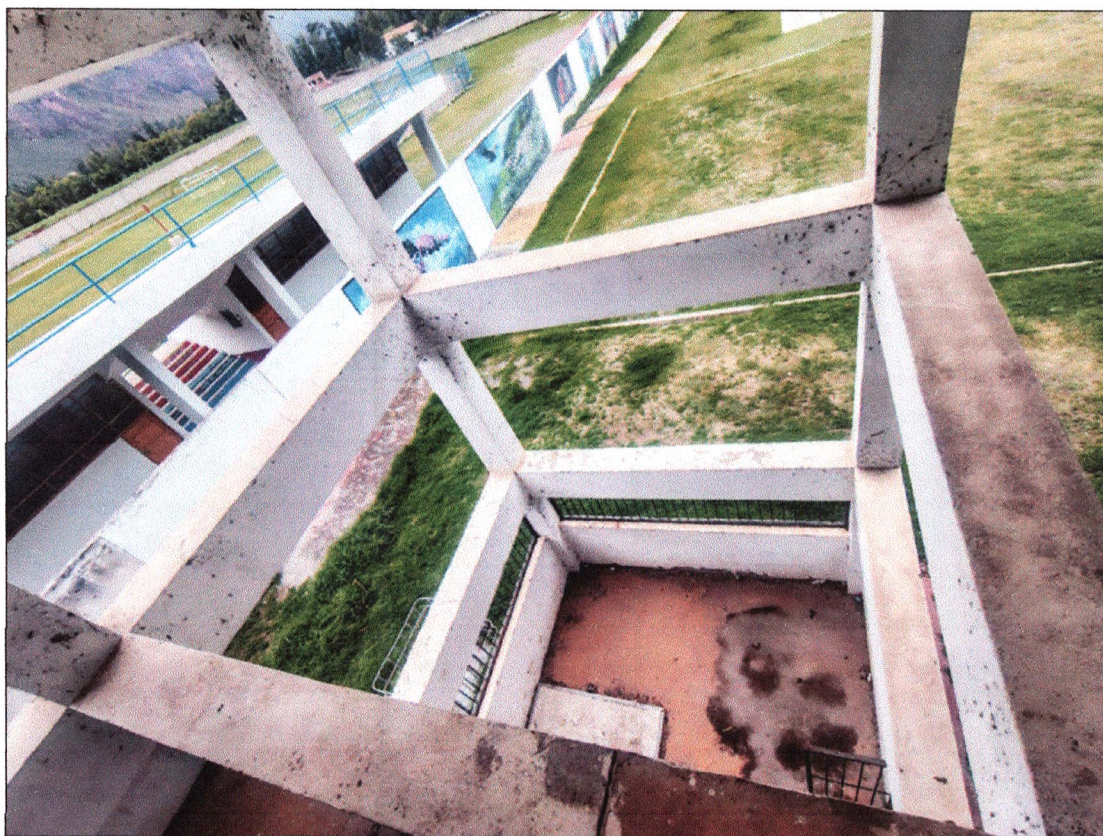
Figura N° 01: Estructura donde se colocará el fibrocemento por la parte interior.
