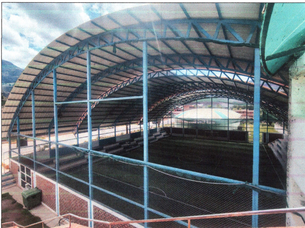
Figura N° 01: Tímpano donde colocará la malla raschel.
